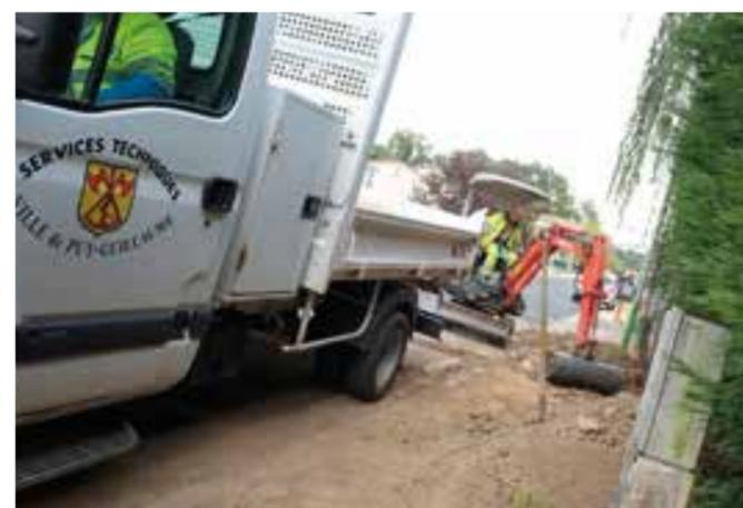
Le mur de la gendarmerie de Puy-Guillaume était fortement fissuré et faisait craindre un risque d'éboulement pouvant mettre en péril la sécurité des passants. Sa construction d'une autre époque, en parpaings et à même le sol imposait son remplacement.
