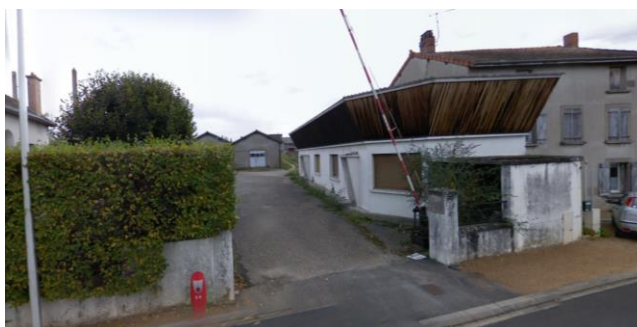
Accès actuel depuis la rue de Verrerie
