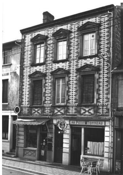
Maison située rue Joseph Claussat recensée au patrimoine général,
