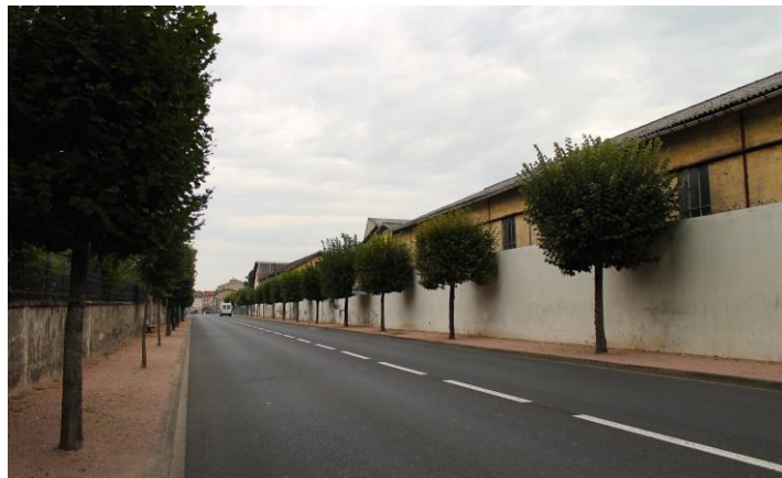
Entrée au droit de la verrerie
