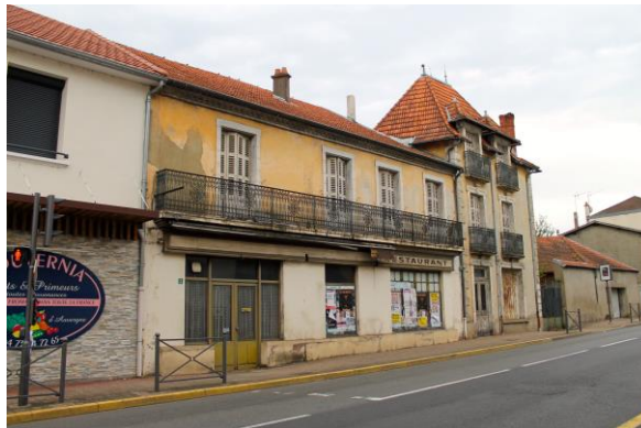
Locaux vacants dans le centre bourg
