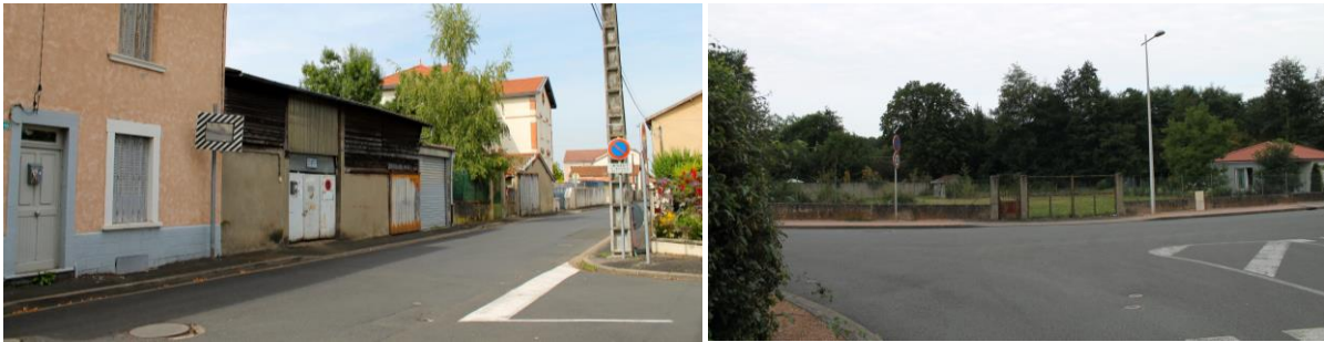
Des mutations du bâti potentielles pour limiter le recours aux extensions urbaines et requalifier le centre bourg, des « dents creuses »
